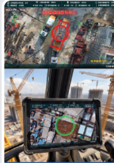
油塘碧雲道地盤甲公營房屋發展計劃建築工程
