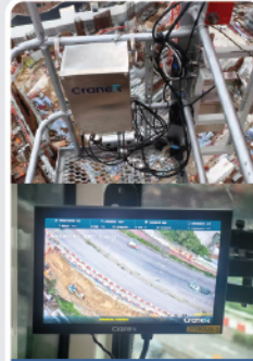
上水第四及三十區一號第二期公營房屋發展計劃建造工程
