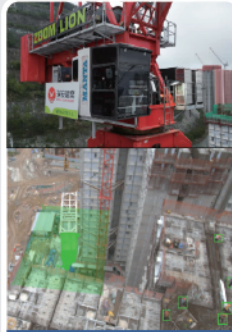
安達臣道石礦場R2-6及R2-7地盤公營房屋發展
